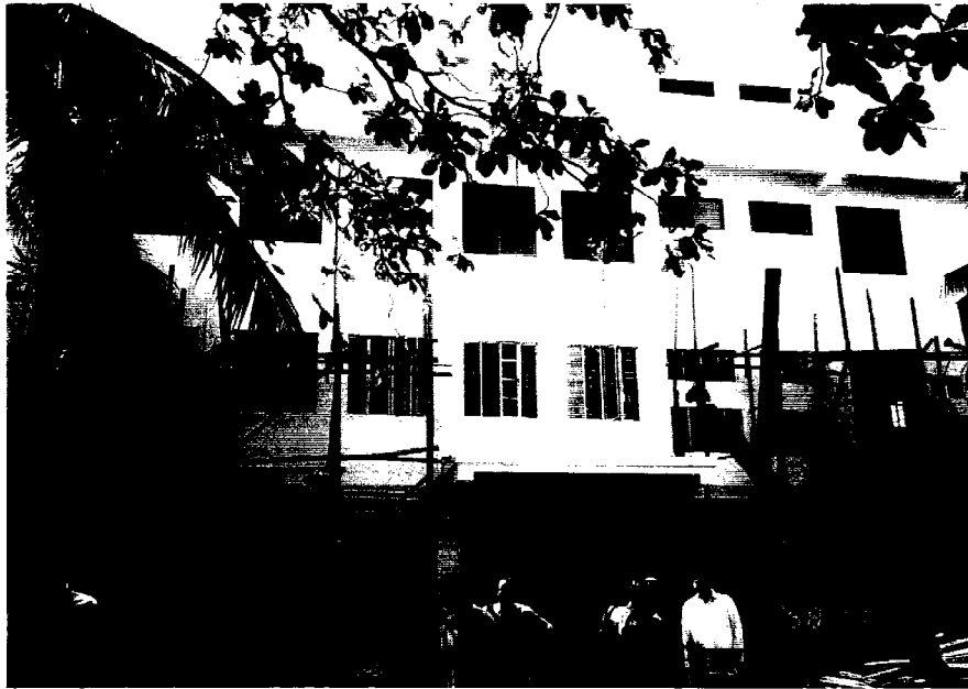
改修中のパシグ市ソーシャルハイジーンクリニック
