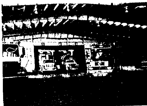
Ingreso de residuos a la estación de transferencia. Los residuos serán transferidos de vehículos de recolección a tractocamiones.
