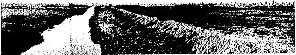
建設予定地全景：東側より望む。
