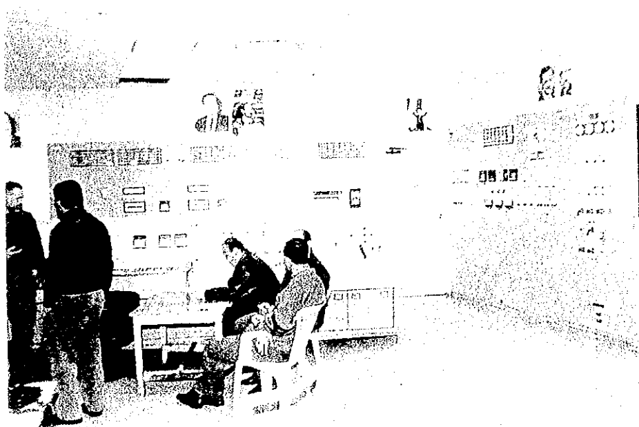
バナアス火力発電所 3, 4 号機 中央制御室
