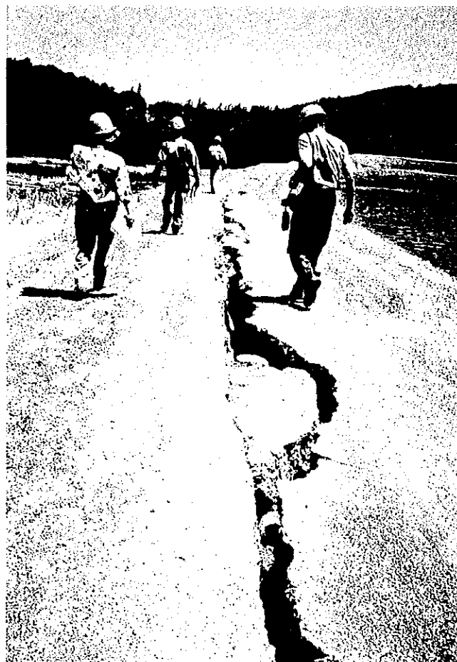
堤体に入った亀裂 (昨年の地震の被害)
