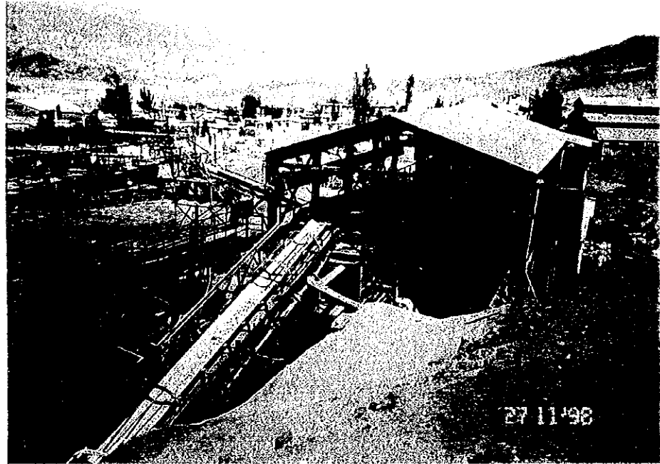
破碎工場と受入コンベヤー
