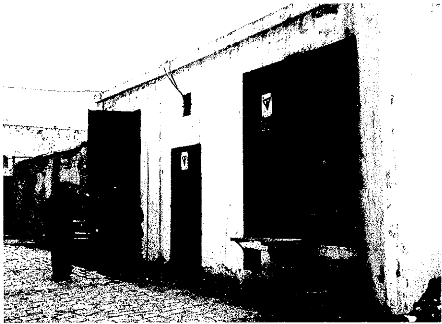
写真13. No.109 配電所 (“乙女の塔”の下)
