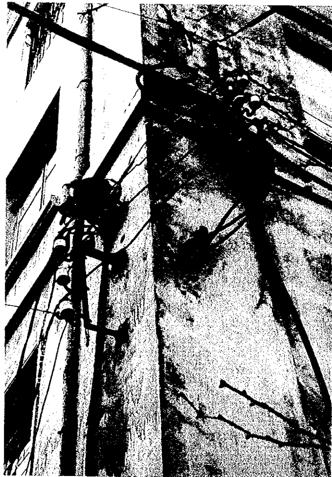
写真18. 低圧配電線（老朽化した屋測配線）
