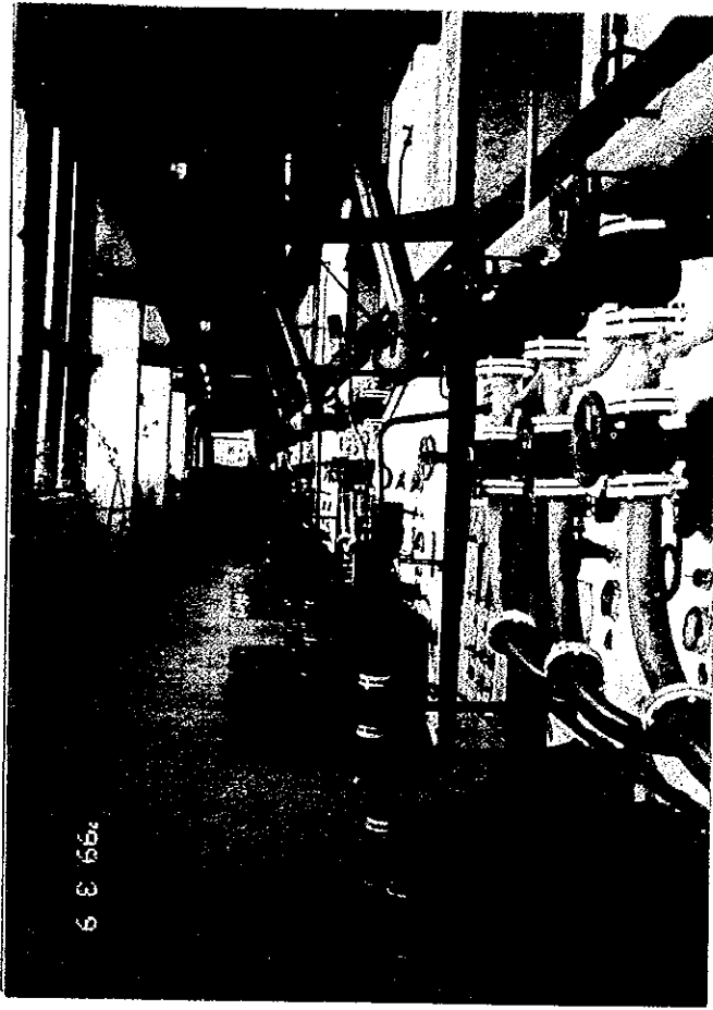
写真23 地域熱供給プラント の温水ボイラー群
