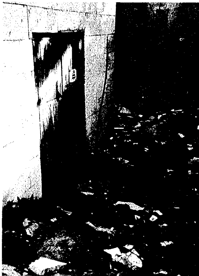
写真4. 同配電所高圧側入り口付近はごみ捨て場になっている。
