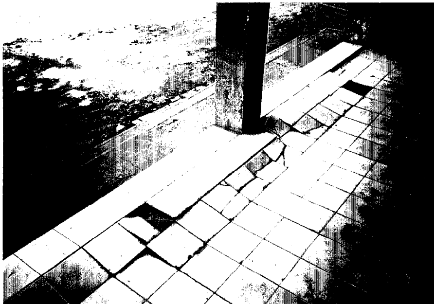
▽ 同センターの老朽化した床
