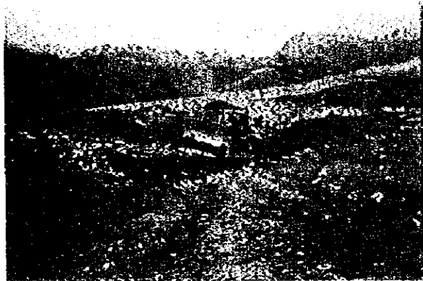
Las basuras son niveladas e inmediatamente cubiertas por una capa de tierra
