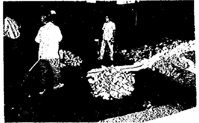
Separación de dos segmentos diagonalmente opuestos y mezclado de los residuos restantes hasta obtener la reducción del residuo al volumen deseado.
