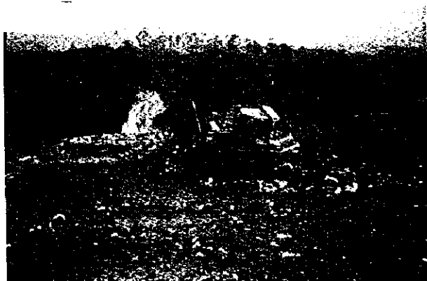
Inmediatamente después de la descarga de la basura, la misma es esparcida y nivelada con tractores.
