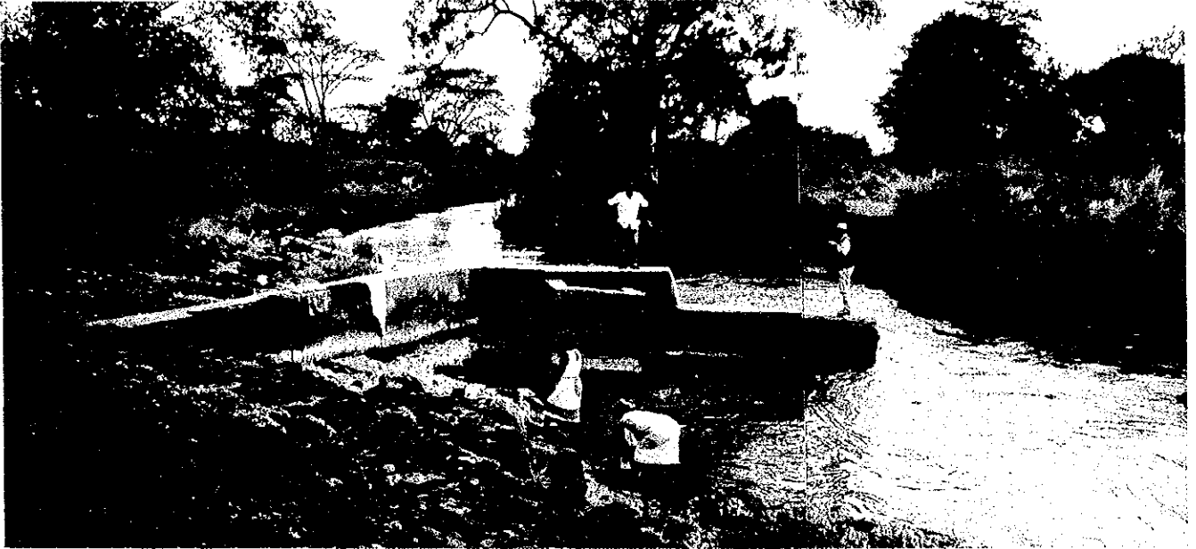
Ruungu/Karocho 地区の水源となっている取水工（1997年の洪水により右岸側が流失）
