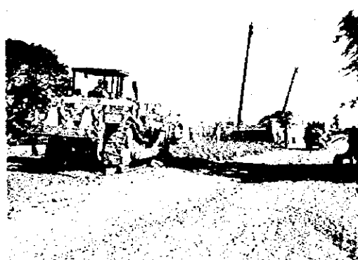
▲カンボジアでの国道修復工事
