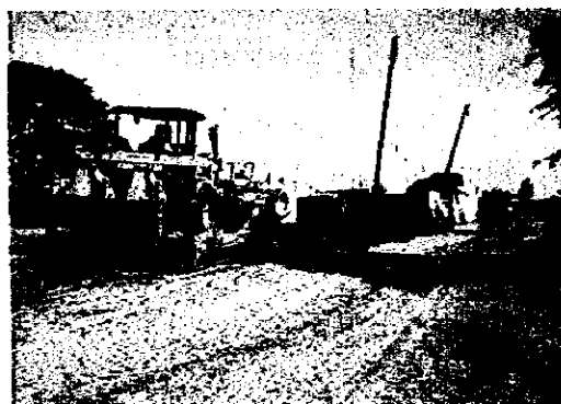
▲供与された機材による道路建設工事
