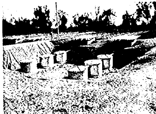
▲ラヨン・ステーション土壌改良試験現場
