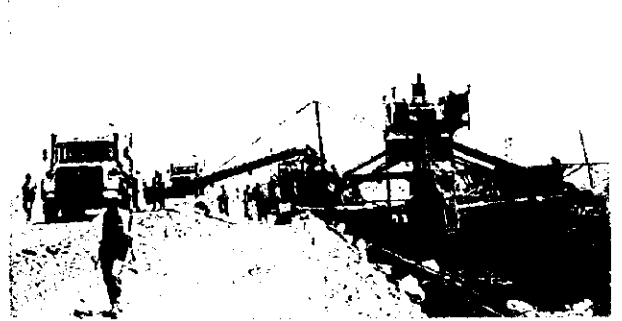
支線水路施工状況
