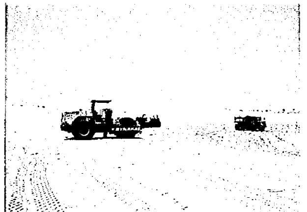
幹線水路74Km地点の施工状況 (締固め)
