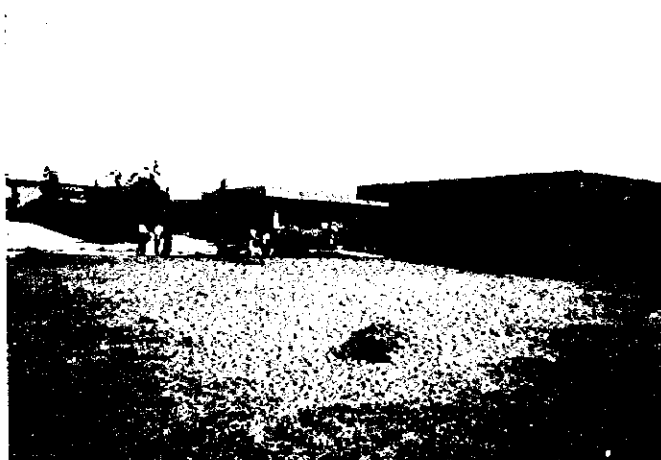
同病院内MCHC建設予定地
