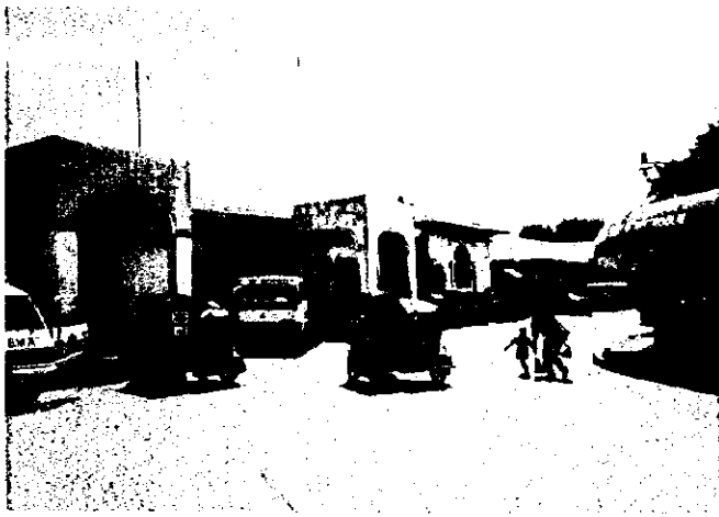
1.1.0 バターン州病院, バランガ (Bataan Provincial Hospital, Balanga)
