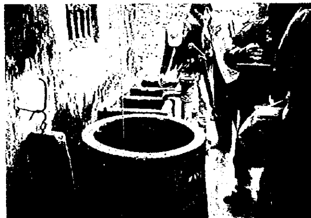
手振り井戸、ハンドポンプ及び濾過器
