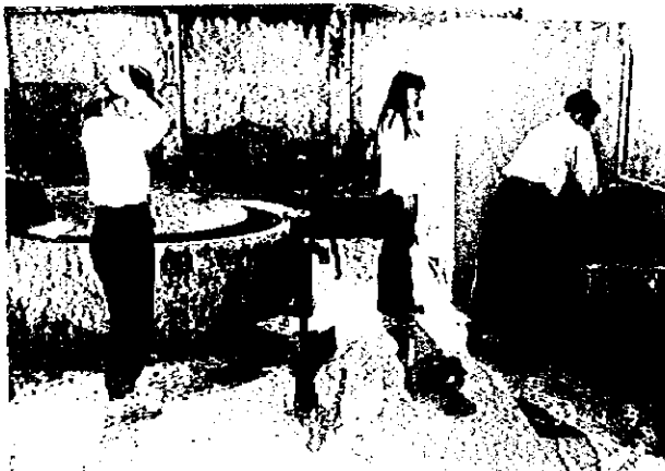
県人民委員会庁舎内部の大口徑手振り井戸及び ハンドポンプ
