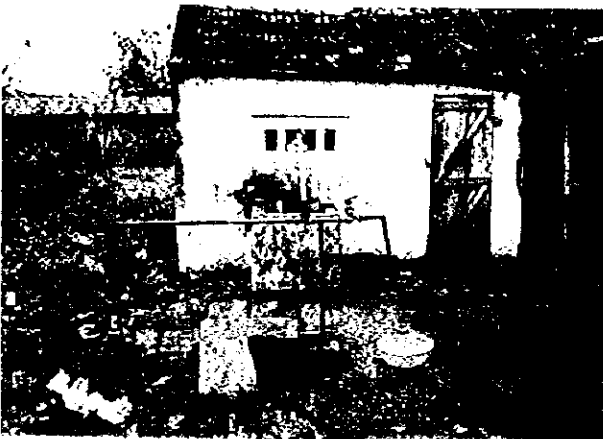
Van Thang コミューン内にある紙工場にて モーターポンプで汲み上げている井戸 (深度 40m、水質良)
