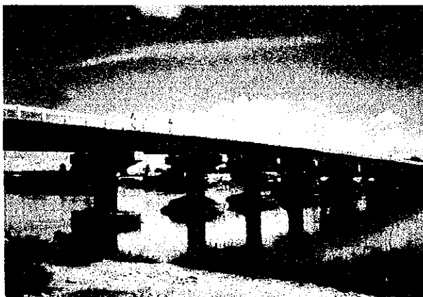
鉄筋コンクリート橋 Midsayap-Dulawan-Tacurong道路, Maguindanao州
