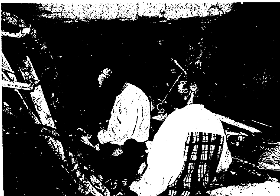
㉒ アディスアベバ市内局の 紙絶縁ケーブルの 心線対照 (2)
