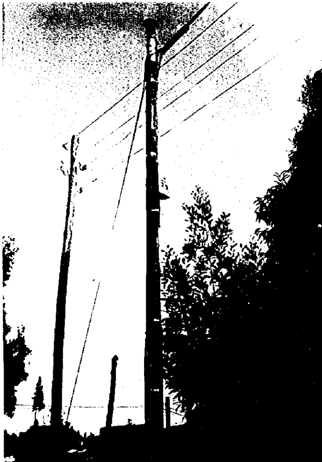
③② アラーダ局の直埋ケーブルの立ち上げ (日本の無償資金協力)
