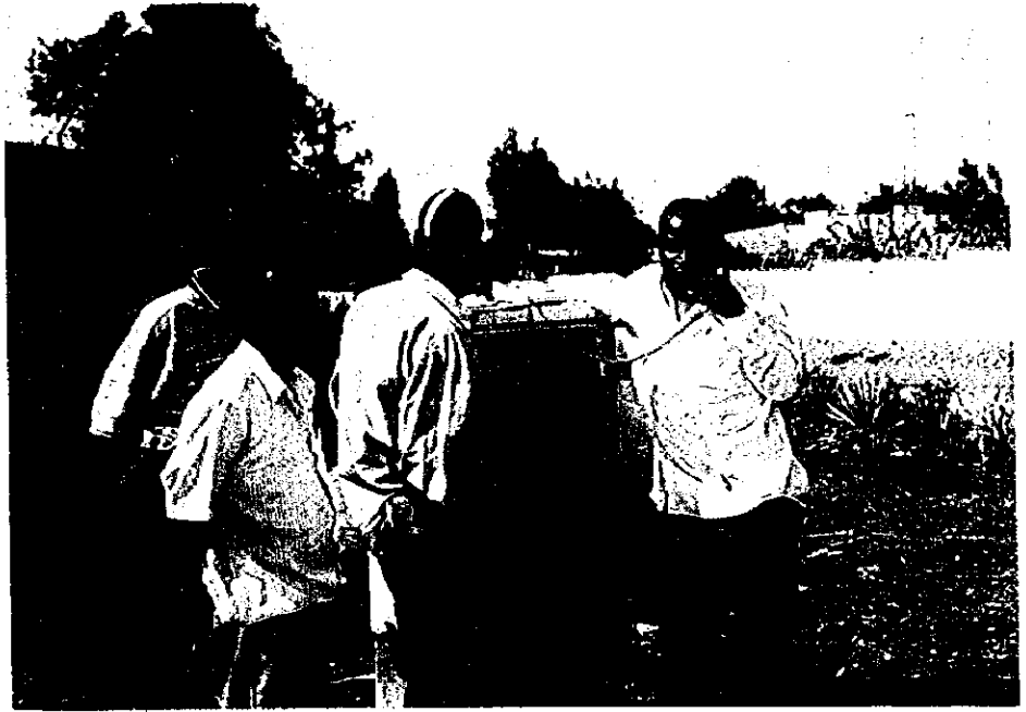
⑩ 切替盤(キャビネット)での 直営工事(ルサカ市内)
