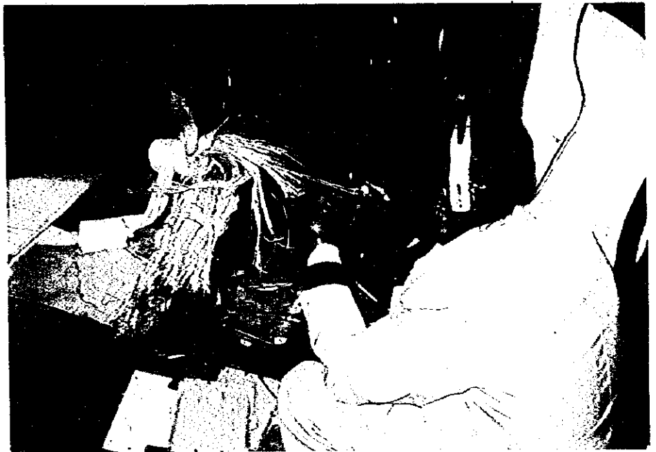
㉑ アディスアベバ市内局の 紙絶縁ケーブルの 心線対照 (1)
