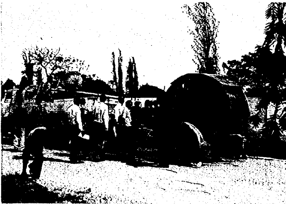
㉑ ルサカ市内の ケーブル工事
