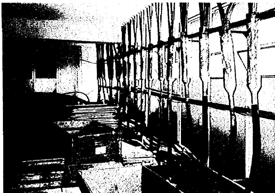
②⑦ 一次ケーブルのMDF 立ち上げ (アデイスアベバ市内アラダ局)
