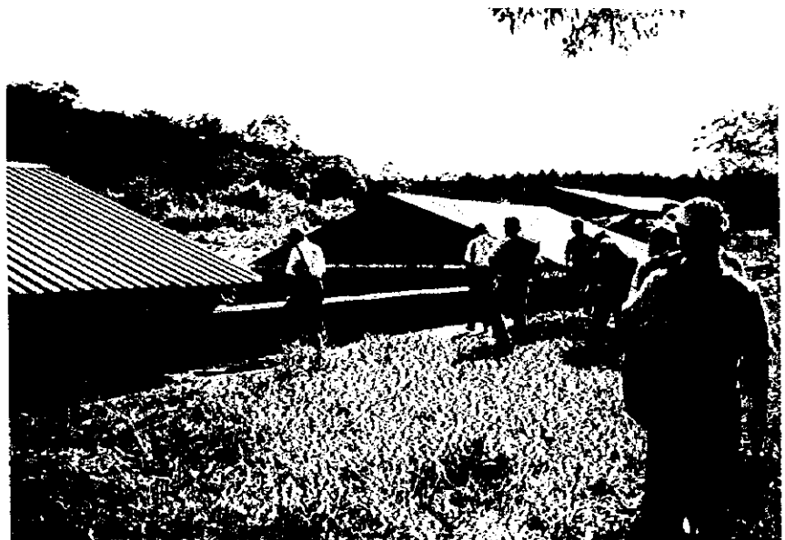
▶ 種子乾燥庫 屋根がスライド式に移動する
