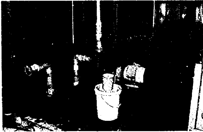
機械室内部 (海水取水ポンプ)
