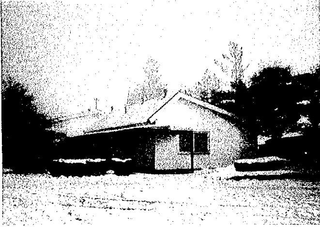
③1 RIBNIC-Previja 既存校舎外観
