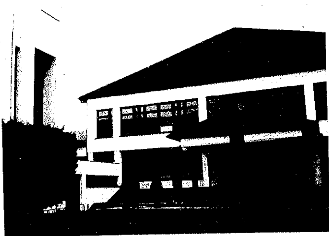
③5 ギリシャの援助で建設された BANJA Luka にある一番きれいな学校の 外観
