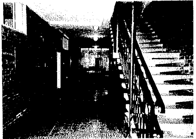
⑧ TUZULA(Canton 3) Pasci 既存廊下床の端部が下がっている
