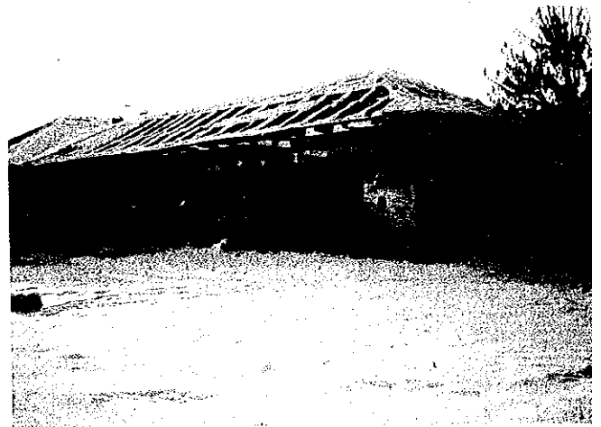
②2 ORASJE(Canton 2) Prud 内戦でダメージを受けた既存小学校外観
