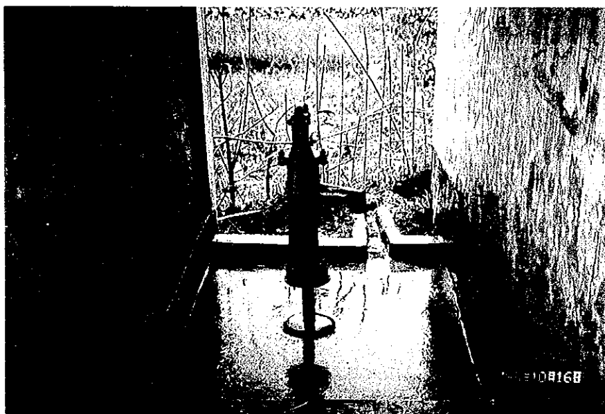
付帯施設の状況
