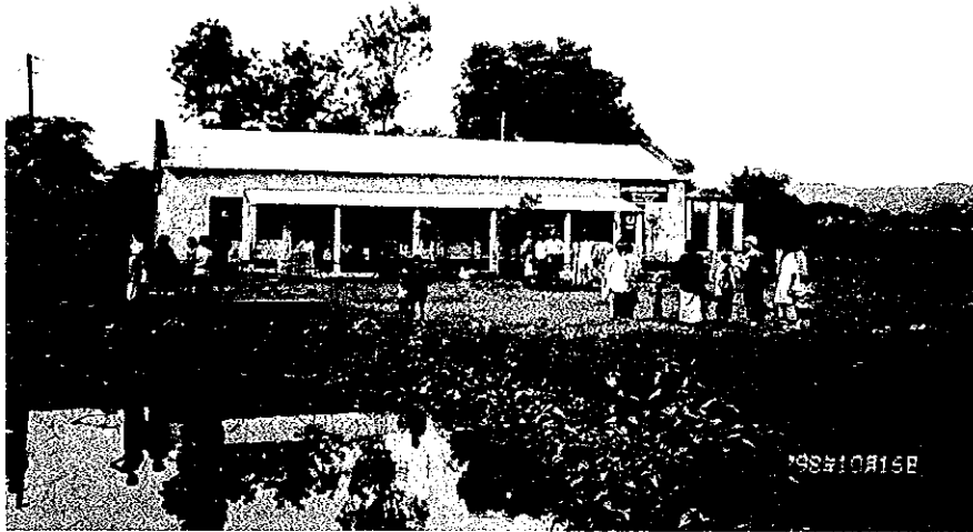
学校敷地全景
