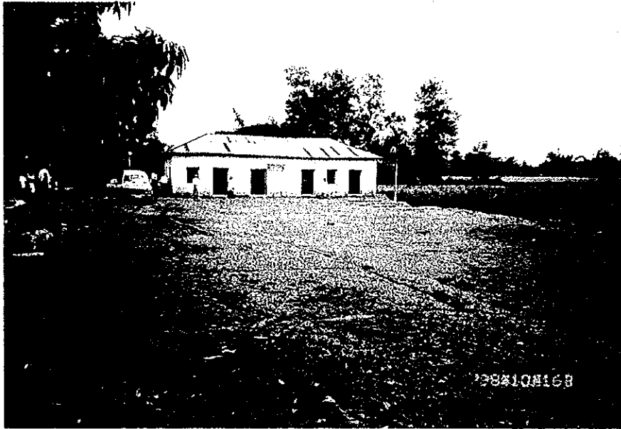
学校敷地全景
