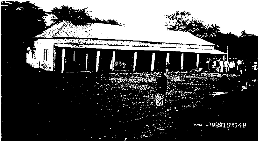
学校敷地全景
