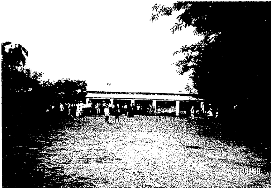
学校敷地全景
