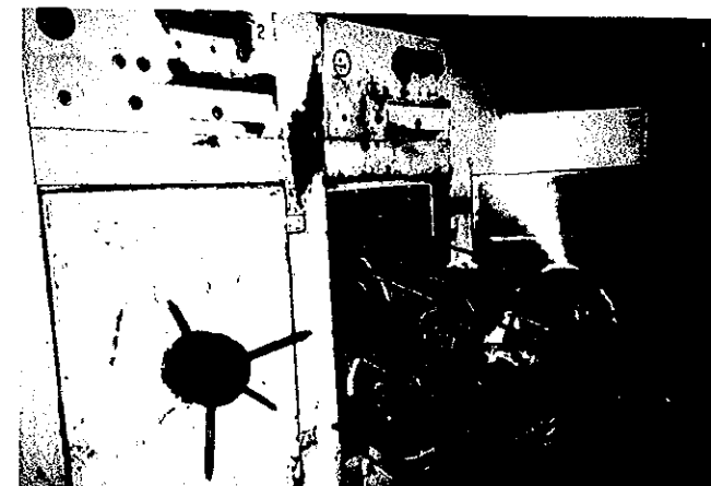
高圧蒸気滅菌装置 / リネン滅菌室
