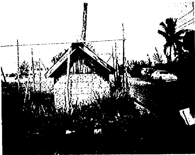
写真 17. 主配水管の途中、給水地区の中央付近に設置されているブースターポンプ小屋。
