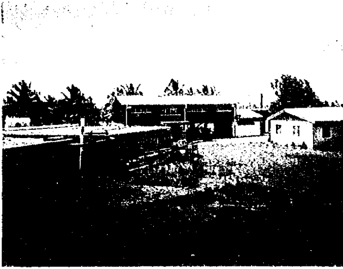
写真7. オーストラリア政府の援助により建設された配水池管理棟。1階がワークショップ、手前右は倉庫。左に配水池が見える。
