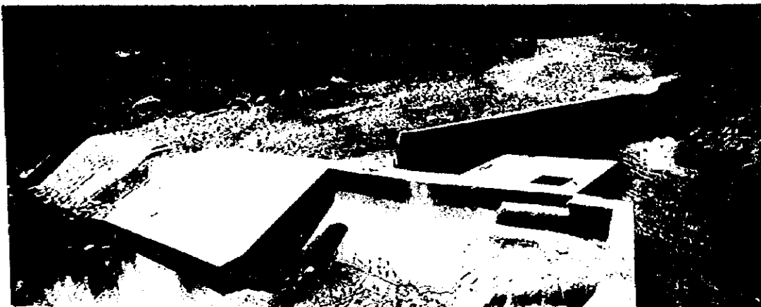
1. 取水工（グラナディージャス川） 堰堤が連続していないため、乾期に取水が困難となる。
