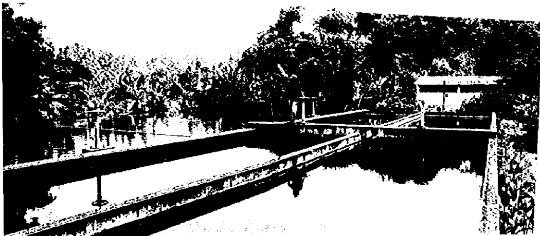
2. 浄水場 手前：普通沈澱池 左奥：緩速ろ過池
