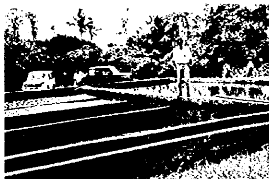
2. 前段ろ過池 取水工付近に濁度負荷を軽減する目的で設置されている。
