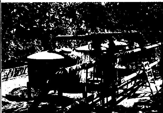
3. 圧力式ろ過タンク 計器が全て故障しており、ろ過状況が確認できない。
