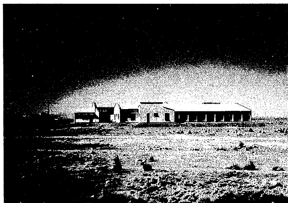
オル口県 本計画用に新設された 機材倉庫及び事務棟
