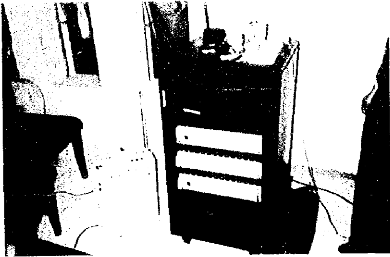
写真-18 講堂操作室の簡易 PA ラック (3階)
