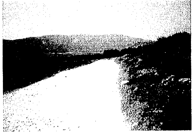
写真8. ヘブロン周辺未舗装道路
