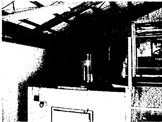
レラ・サイト: 既存プレート製氷機: 機器は正常に作動するが、海水冷却系統に問題があり作動出来ない
