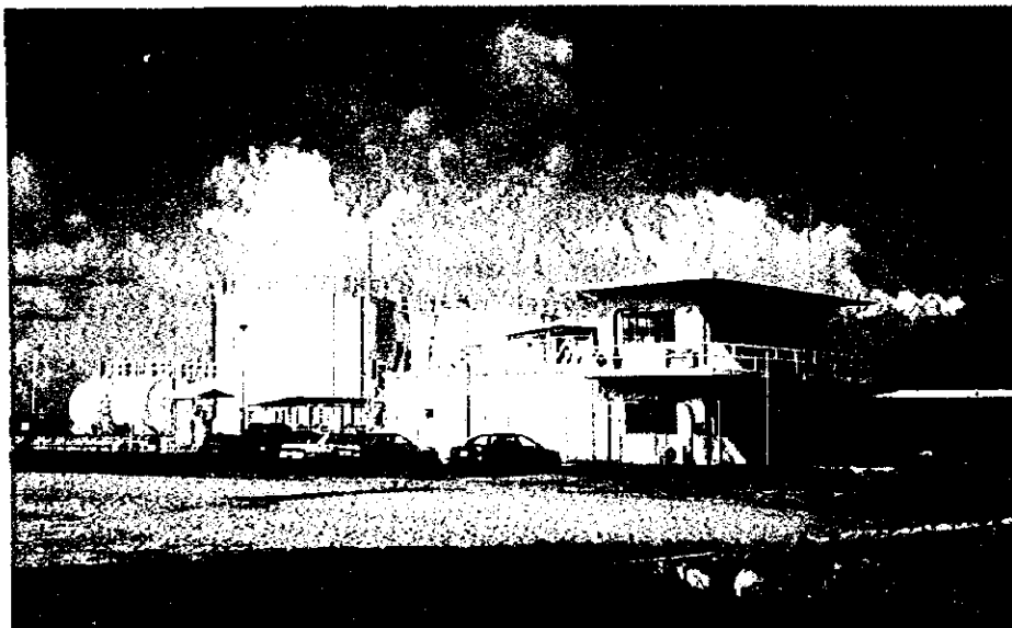
写真-7 石油製品貯蔵施設
