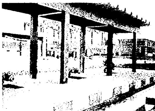
サン・ミゲル処理場 (タンクローリー受入設備)
