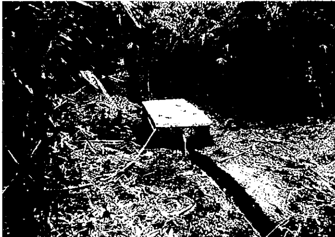
溪流取水型自然流下方式 (グラビティー方式)
