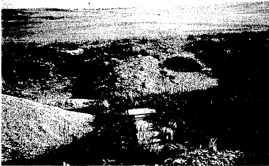
豚舎廃水処理場
