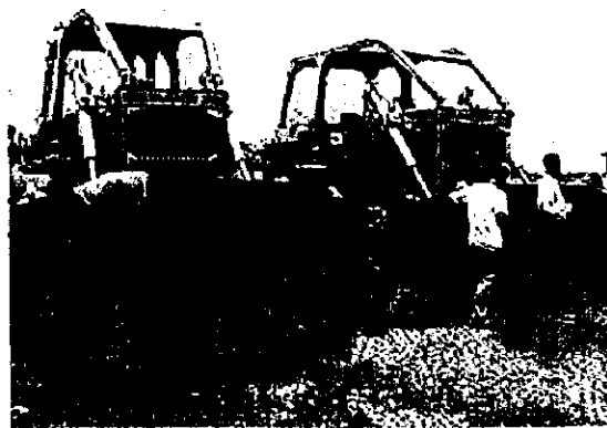
写真8 カナカントパ入植地に供与されたブルドーザー
