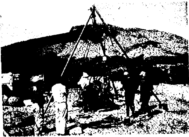
ポンプ場建設予定地ボーリング調査 (ブロック D)
