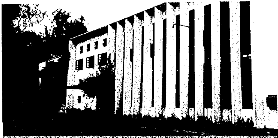
SOB木館建物の西側にあるLPO（製版印刷部）建物の正面。本計画の印刷用機材及び製版用機材はこの中に設置される。
