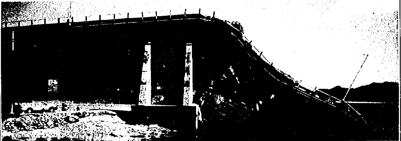
71-1側の桁及び橋脚の崩壊状況、30-1側と同様の損傷が観察できる。
