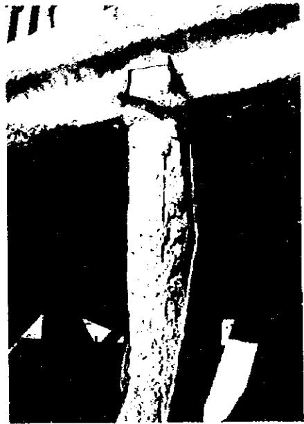
① 突堤棧橋の先端部、柱の損傷・欠落。
