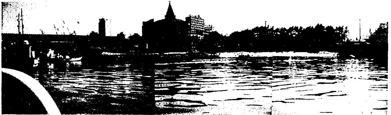
⑩ 漁港泊地の全景（冷蔵庫棟～倒壊護岸～ドック；1998年8月）
