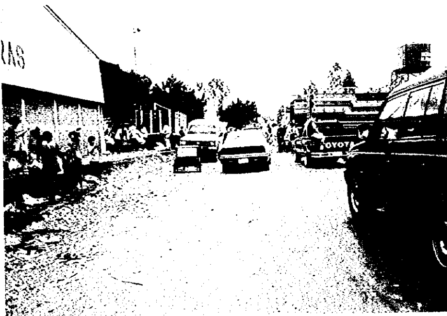
送水管敷設予定地の状況（サバナ・グランデ付近）
