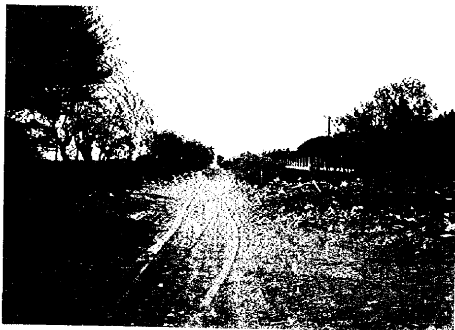
送水管敷設予定地の状況 (ポンプ場～サバナ・グランデ間の旧鉄道敷跡地)
