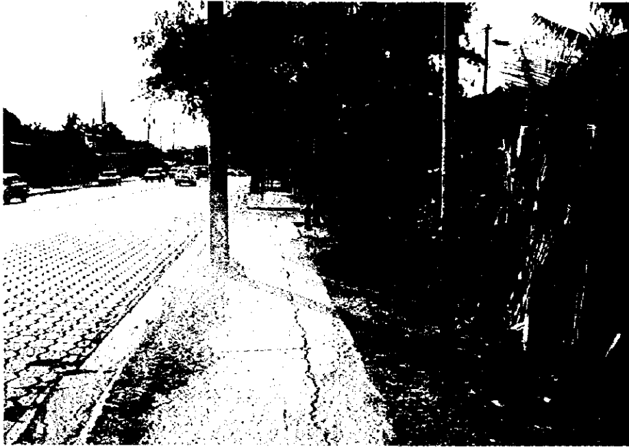
送水管敷設予定地の状況（ラス・アメリカス配水池付近）
