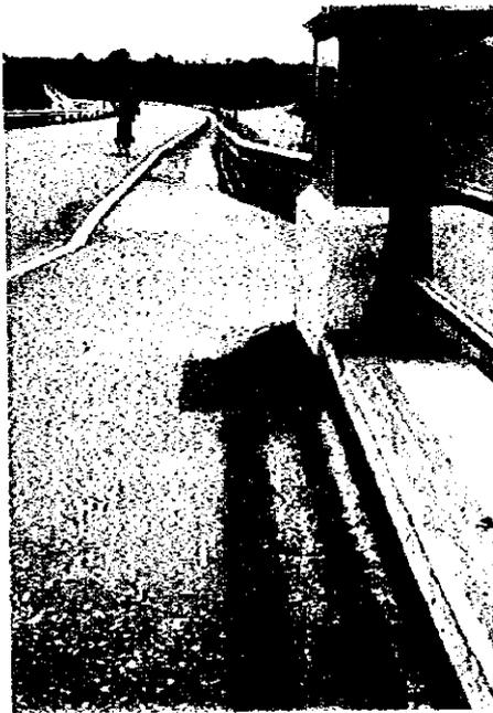
写真-C5 歩道アスファルト部の波打ち状況
