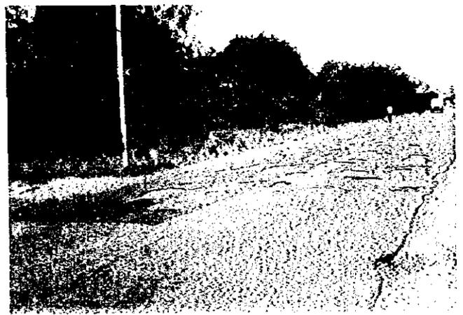
写真-C12 ムトワバ～キリファイ間の舗装状況で、キリファイ橋約2km手前地点より損傷が激しい。
