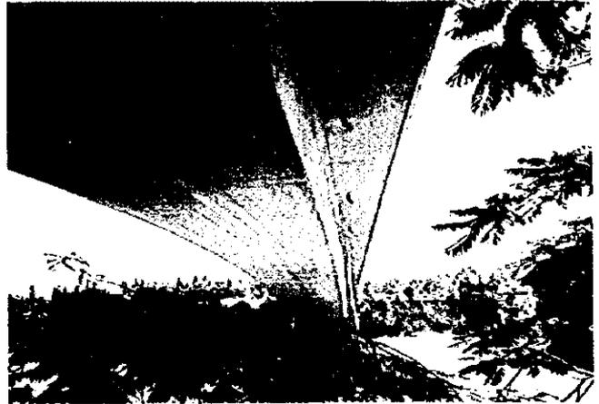
写真-C2 主指外面の状況で、排水溝に工夫が見られるため雨水跡がない。
