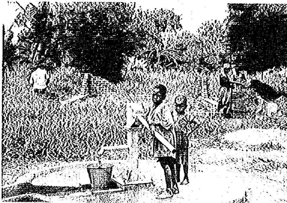
写真4 建設工事 (井戸完成後 : MAMBEGWA)
