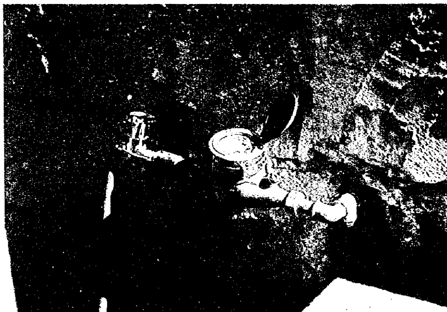
14. 家屋接続の状況 (アンマン郊外)
