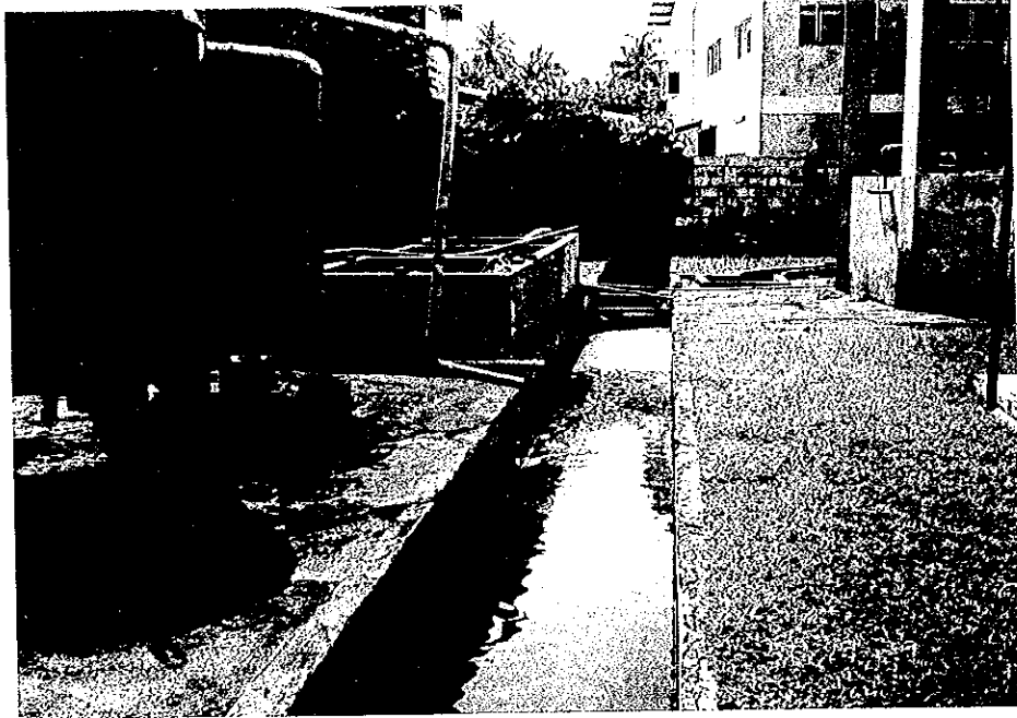
排水路（壁の向こうは敷地外（そのまま川へ））
