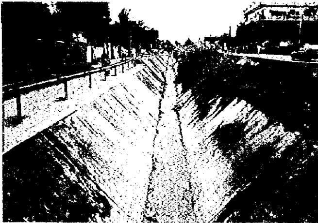
比較的きれいに整備されたヨブゴン地区上流部の雨水排水路
