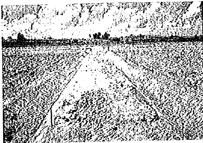
完成した水田、耕作道小用水路 (ラロバオ村) 耕作道巾員 2.0m 水田区画 20m×50m=1,000m 2
