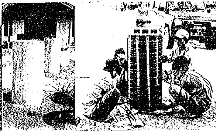
鉄筋コンクリート管製作指導。 井戸枠、暗渠に使用するため、鉄筋コンクリート管（φ400mm、L=1.00m及びφ800mm、L=0.50m）の製作を農民グループに指導した。
