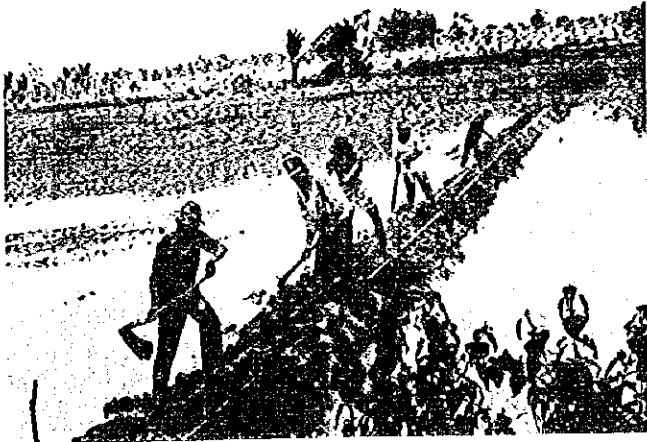
水田造成 (ラロバオ村) 小用水路掘削耕作道造成は農民グループの作業で受益農民以外の農民も 出役する。丁張りはカウンターパートが設置している。
