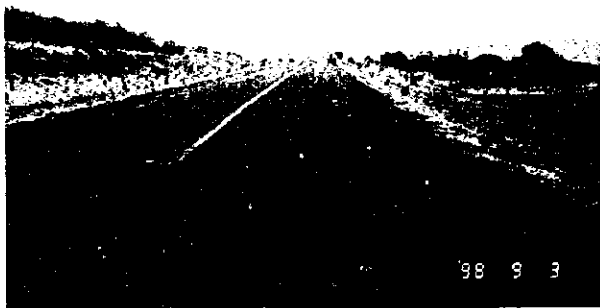
C18 カルング付近 アフリカ開発銀行により改良がなされたばかりの区間。舗装はDBST
