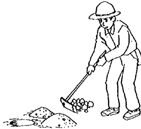
② Excavación de la cepa (2) Se sacan las piedras que se hayan encontrado en el trabajo de hacer cepa, colocándolas lejos de la cepa.
