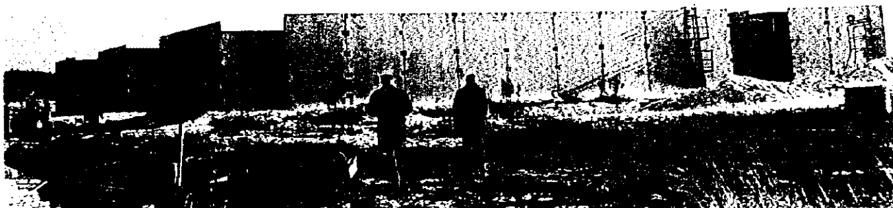
ビルザイ市新下水処理場の建設予定地（建設が中止されたままのプラント）
