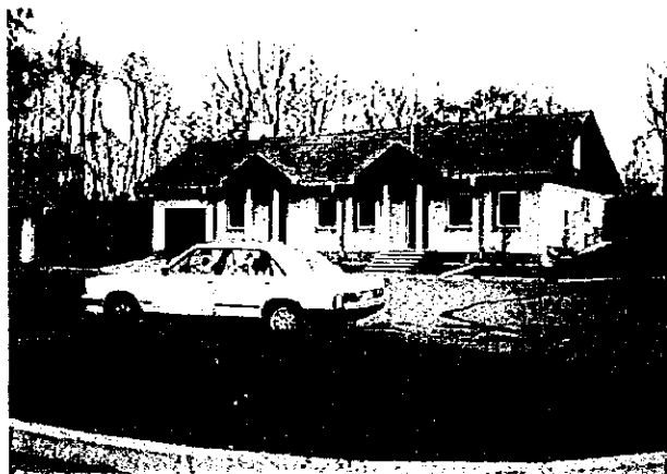
下水処理場の管理棟
