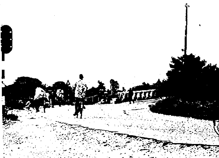
マンゴチ側橋梁入口の様子。 橋梁は一車線片側通行のため、信号により通行を規制している。
