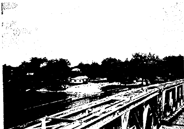
マンガチ橋下流右岸の様子。 新橋建設のため、小屋の移設 が必要である。
